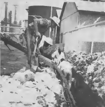
TRAHADORAN TA pone canasteri di here den un sanja banda di Powerhouse No. 1 pa conducto di cable pa transformer, y despues nan ta basha concreto. Paretivian ariba ta muestra un vista general.
